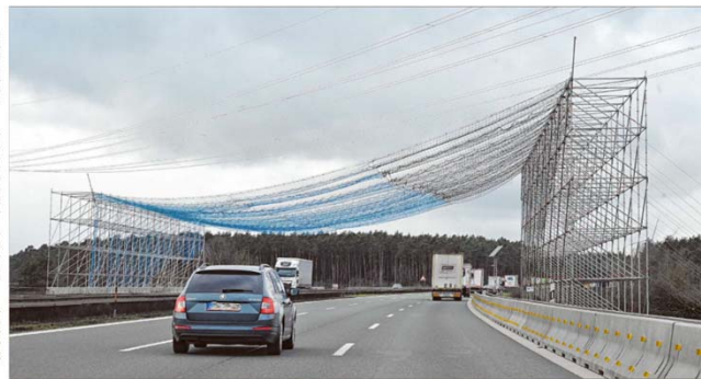
Ein Netz wurde über die A6 bei der Anschlussstelle Ansbach gespannt. Es dient der Sicherheit während der Arbeiten zur Verbesserung der Kapazität der Stromleitung zwischen Winterscheidbach und Müncherebich. Das Foto entstand in Richtung Heilsbronn.
